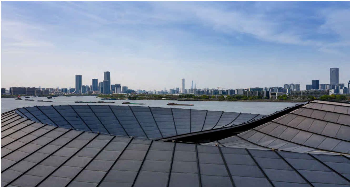
图 13 三港线渡口双曲面屋面
