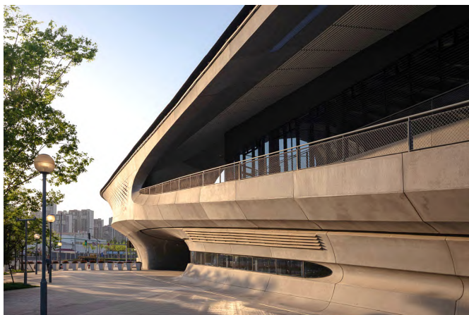
图10 GRC覆层板块拼接与整体形式的关系
